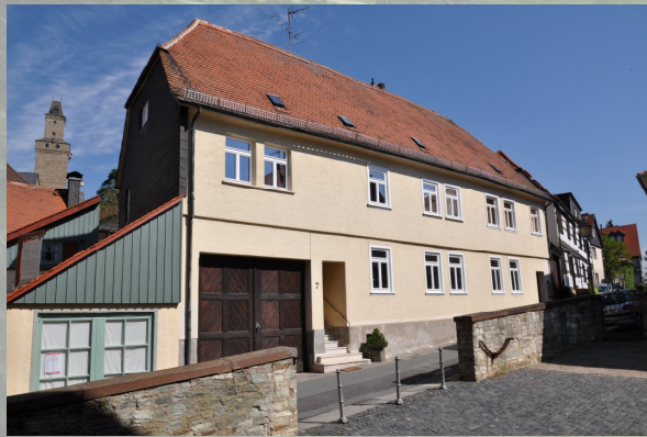
Das Pfarrhaus in der Dopesstraße 7 liegt der Kirche gegenüber. Hier wirkte der Pfarrer von 1786 bis zu seinem Tode im Jahre 1813. Es ging 1870 in Privatbesitz über, nachdem ein neues Pfarrhaus in der Wilhelm-Bonn-Straße auf den ehemaligen Baumschulen des Pfarrers errichtet wurde.
